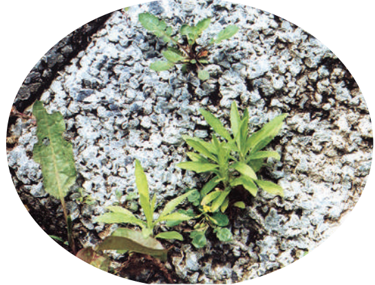
ポーラスの空隙に自生する植物
