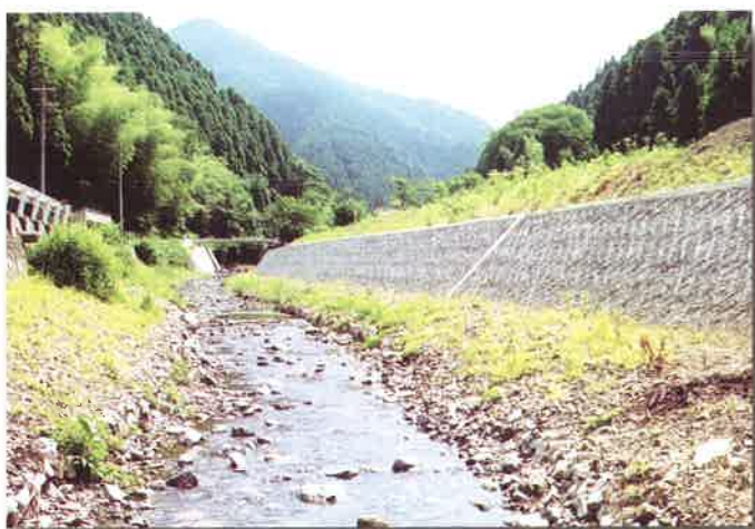
姫路市 砂防中の谷川護岸
