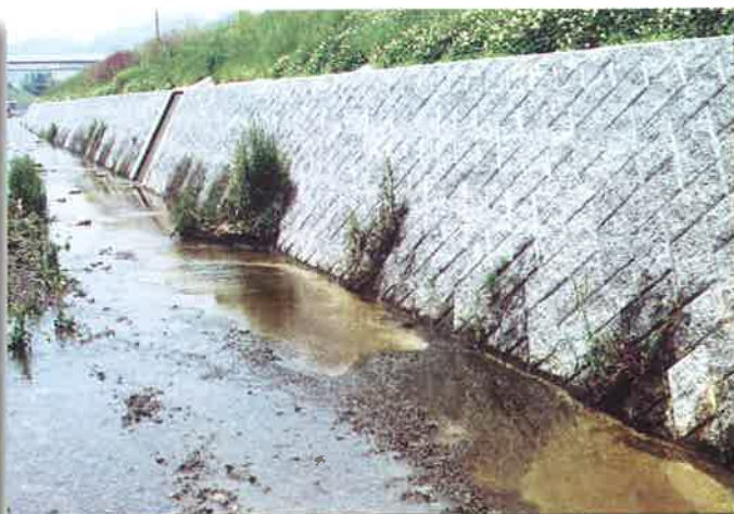
神戸市 淡河川護岸工事
