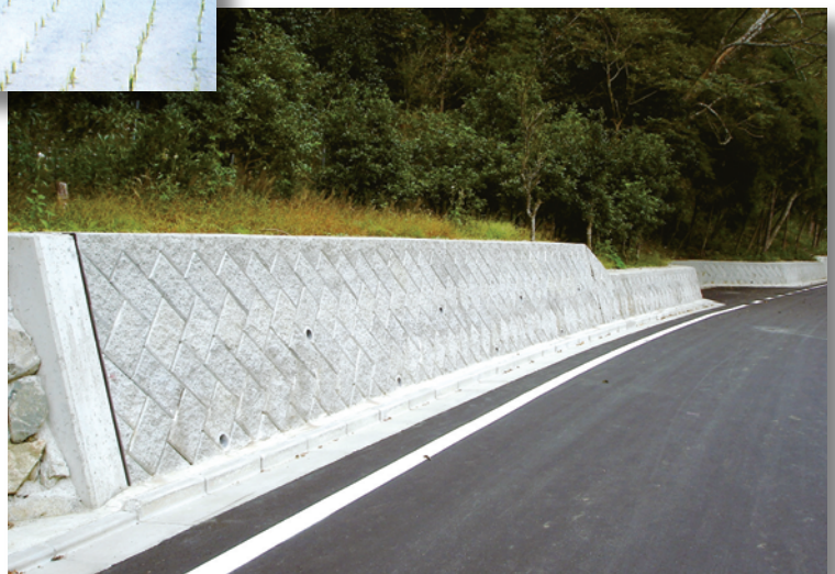
穴栗市 道路改良工事
