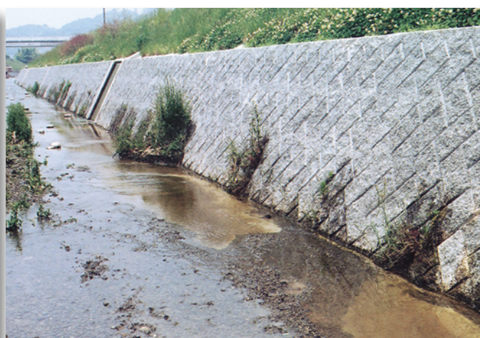
神戸市 淡河川護岸工事
