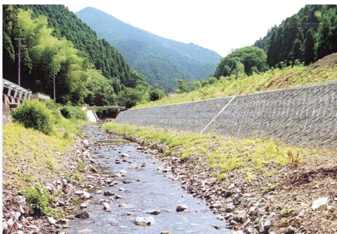
姫路市 砂防中の谷川護岸
