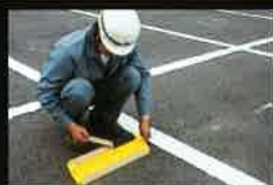
No.2 本体裏の接着テープの剥離紙を剥がします。
