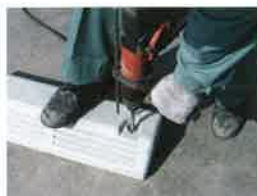
No.1 本体を押さえつけながらホルダーの上から片側の穴あけをします。φ12深さ55mm以上
