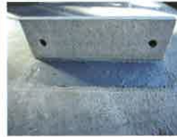
No.2 パーキングボンドスーパを接着面全体に均一に塗布します。
