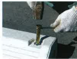
No.3 ハンマーで打ち込む場合はφ10以下の下穴をあけた後に叩き込みます。(ブロック破損防止の為、オプションのハンマー用アタッチメントを使用して下さい。)
