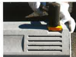
No.1 反射レンズを正面に向けホールキャップをはめ込みます。
