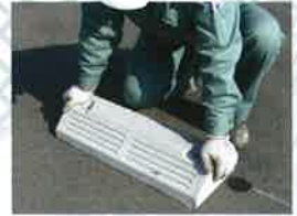
No.5 ブロックを押さえつけながら定位にセットします。
