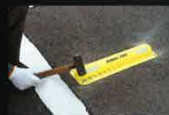
No.5 アンカーピンのソケットを打ち込んだ後、芯ピンを打ち込みセット完了。
