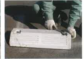
No.5 接着剤硬化後(約2時間後)にボルトを締め付け、ホールキャップをはめ込みます。
