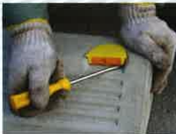
No.1 ホールキャップとブロックのすき間にマイナスドライバーを差し込み、ホールキャップを取り外します。
