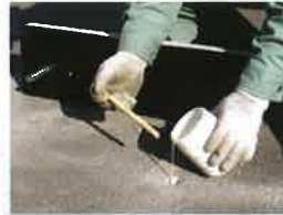
No.3 アンカー穴をブラシで掃除した後にパーキングボンドスーパ(着脱仕様)を充填します。
