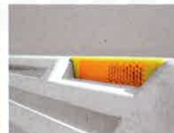
No.2 ブロック天端面と平らになるよう、確実にセットします。
