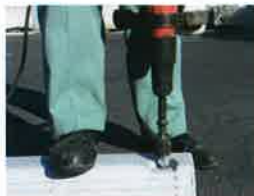
No.2 本体を押さえつけながらプレーカーでアンカーピンを叩き込みます。(オプションの専用アタッチメントか、市販のテーバーアダプターを使用して下さい。)
