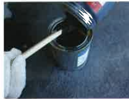
No.1 設置位置を計測し、接地面の汚れ、ほこり、油分を除き、パーキングボンドスーパの主剤、硬化剤を色が均一になるまで攪拌し付属の骨材を加え練り混ぜます。
