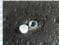
No.4 インサートに養生キャップをはめ込み、取り外し完了。
