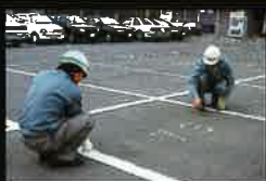
No.1 設置位置を計測し、設置面を掃除します。
