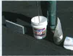
No.3 パーキングボンドのセメント骨材とボンド液を練り混ぜます。(スランプはボンド液添加量で調整して下さい。)
