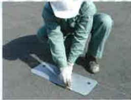
No.1 計測、位置決めをします。 パーキングブロックは製品の破損を防ぐため平滑な設置面へ施工を行います。
