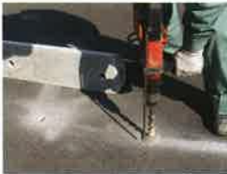
No.1 ブロック位置及びアンカー位置計測後、ドリルにて穴あけをします。 φ30深さ100mm
