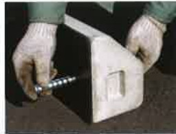
No.2 ゴムシートを間に挟み、アンカーボルトとインサートナットをネジ込みセットします。
