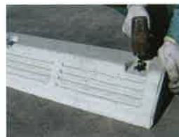
No.3 アンカーボルトを軽く叩き込みます。(締めシロが2~3mm位残るのが適切)※ホルダーのツメがアンカーの樹脂座金にかかるのを確認下さい。
