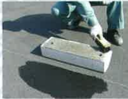
No.2 ブロック及び舗装の接着面を掃除し、ブロック接着面に水打ちをします。 (※ドライアウト防止の為)
