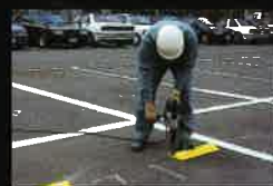
No.4 本体を足で押さえながらピン位置にドリルで穴あけをします。 アスファルト(ドリル径φ7.0深さ60mm以上) コンクリート(ドリル径φ8.5深さ45mm以上)
